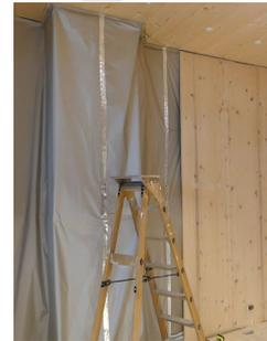
La toile anti-ondes professionnelle PRO-G80 neutralise les ondes hautes et basses fréquences. Elle offre une réduction exceptionnelle allant jusqu'à -80 dB à 1 GHz, excellente quelle que soit la fréquence, y compris avec les ondes 5G. Cette toile est comparable au modèle HNG80 de Yshield, mais disponible en largeur de 1,30 m, vendue au mètre ou en rouleaux de 20 ou 100m (sur commande pour grosses quantités).
