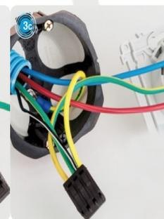
Une protection du champ électrique est indispensable dans toute construction à base de matériaux écologique, bois, chanvre, paille, et devrait aussi être utilisée derrière les murs en placo-plâtre. Gaine préfilée 3G1,5 couleurs au choix, idéale en construction neuve pour sa facilité d'installation, même sans grande connaissance de l'électricité biotique par des électriciens consciencieux.
