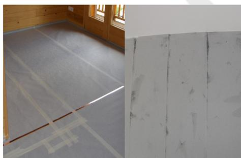
Le revêtement mural EMV est utilisé en une couche pour bloquer les champs électriques basses fréquences (BF). Appliqué en **deux couches, il absorbe les ondes hautes fréquences (HF)**, ce qui lui confère un atout unique lors du blindage d'une pièce : les résidus liés à des fuites dans le blindage principal des autres murs sous forme de réflexions multiples d'ondes HF sont ainsi évités.
